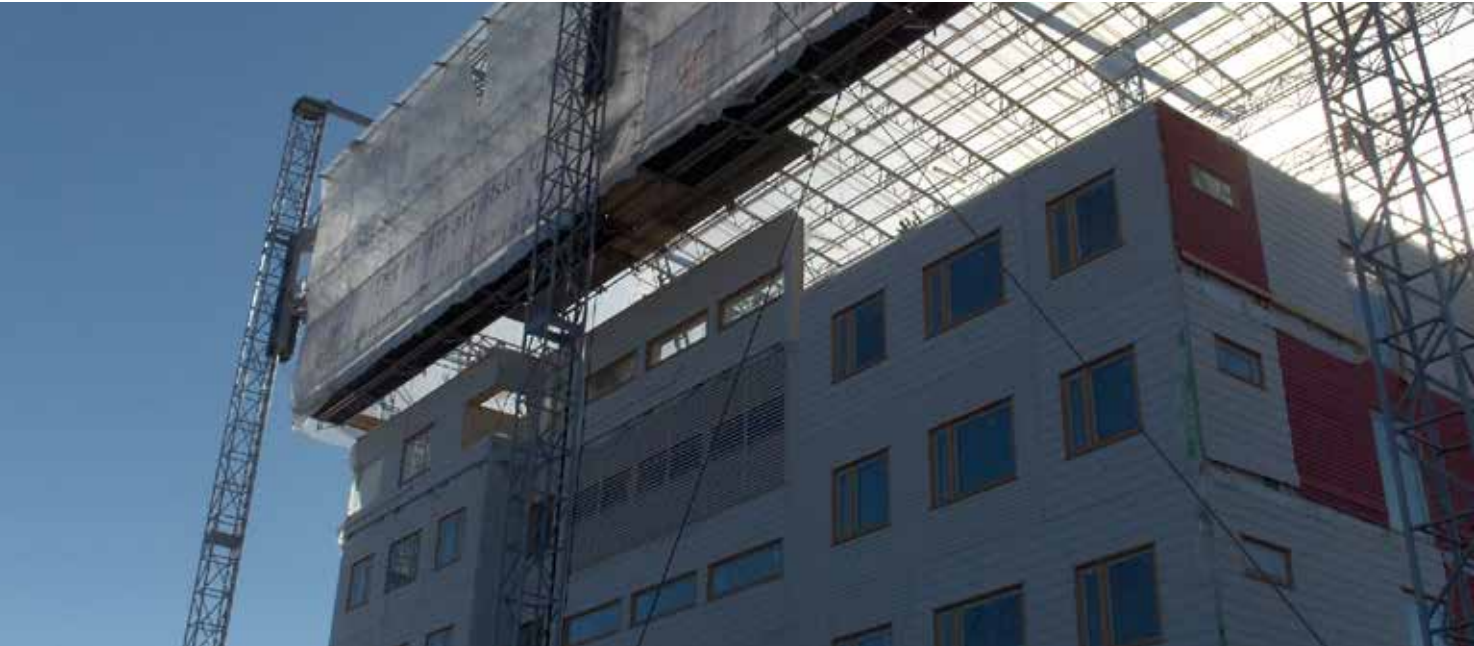
Träkonstruktioner har en lång tradition i Skandinavien. Limträbalkar och färdiga träsektioner monteras vid större bygge.
