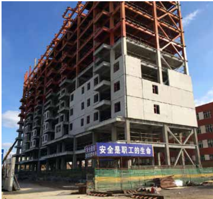
Utfackning av helväggselement i Kina.
