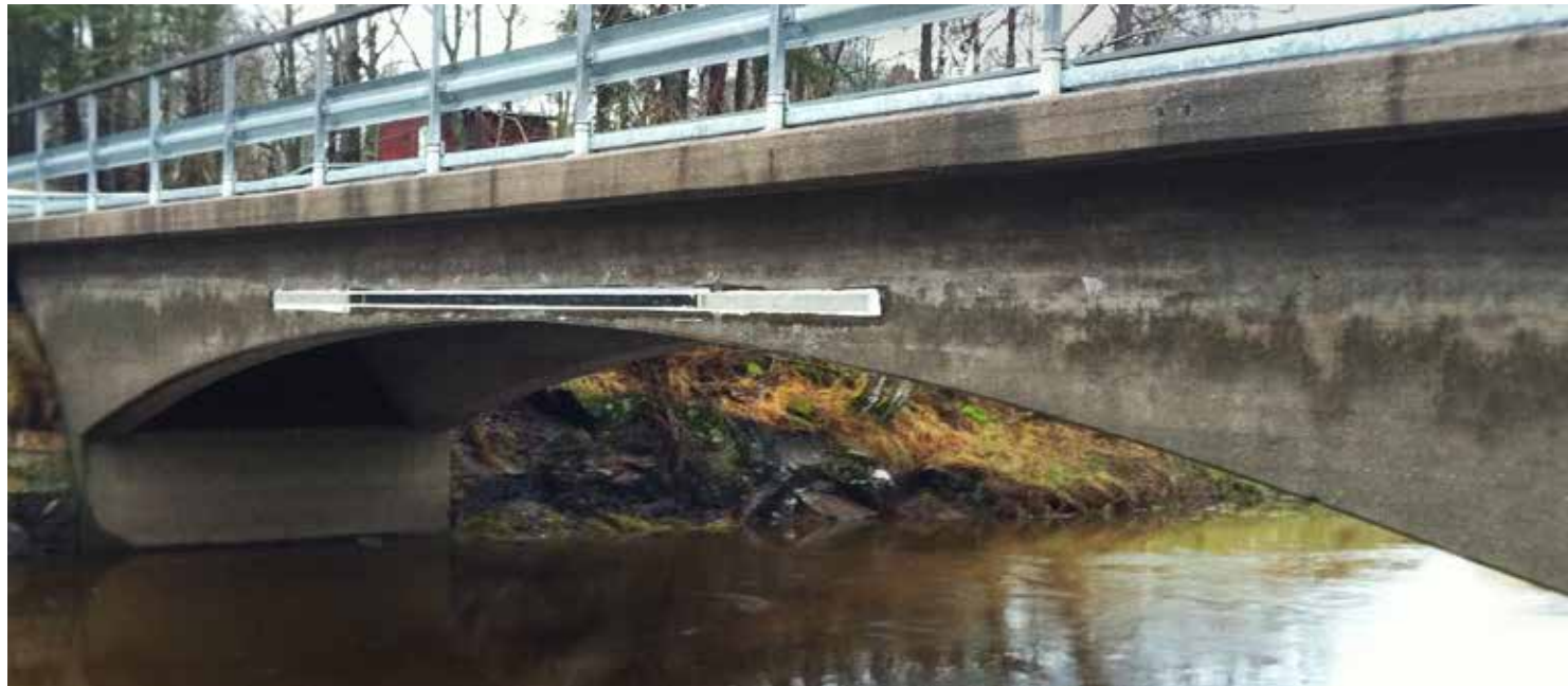
Förstärkning med FRP-material i en betongbro.
