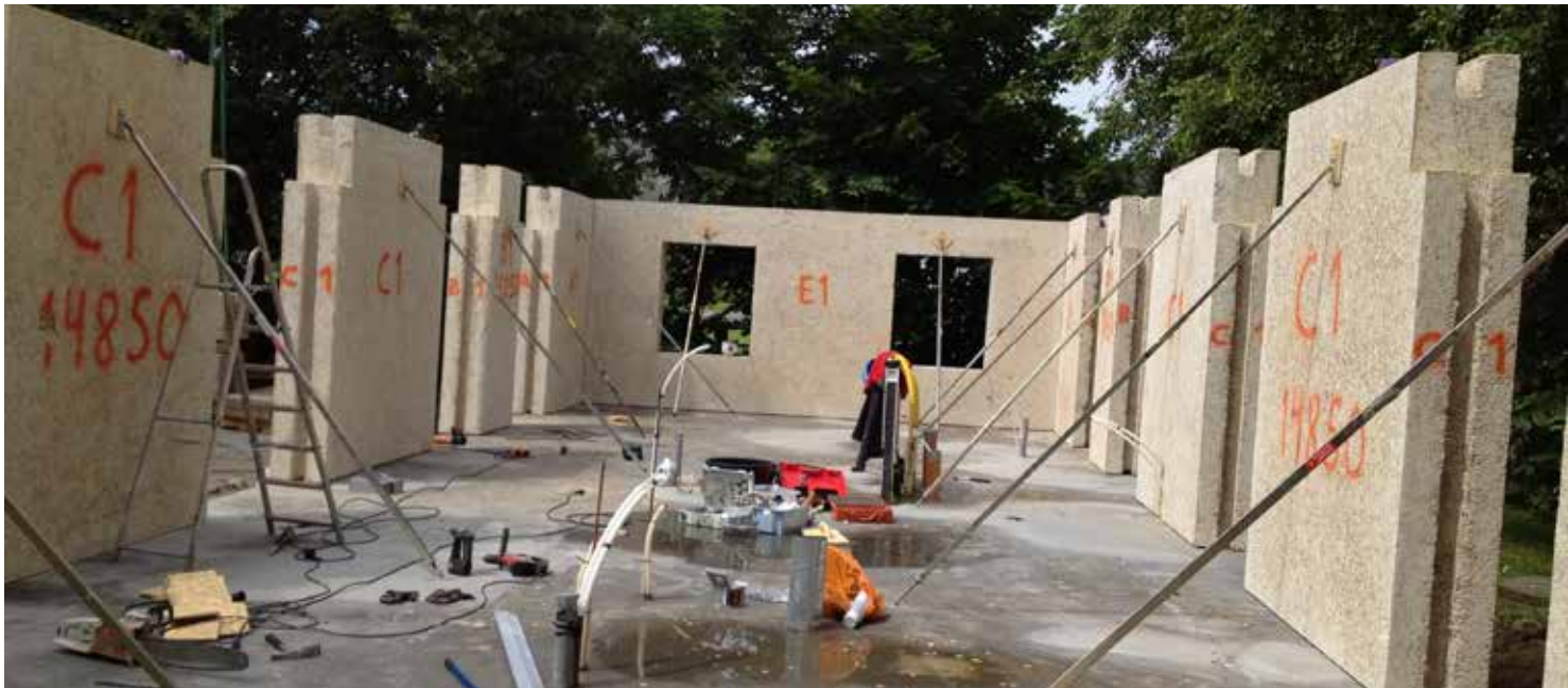
Montering av Träullit väggelement vid projekt i Mellby.
